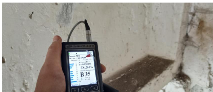
Рис. 1. Контроль прочности бетона балки покрытия пристройки
