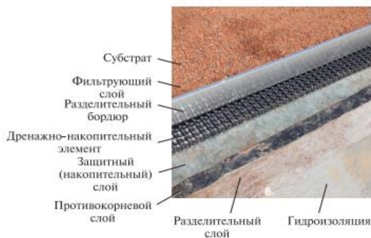
Рис. 1. Структура зеленой крыши экстенсивного типа
