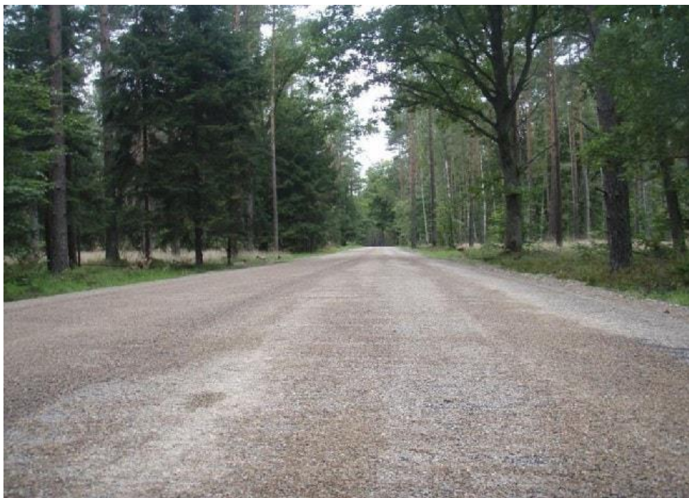
Рисунок 8. Пример укрепленного неорганическим вяжущим проезда при незначительной интенсивности движения лесозаготовительного транспорта
