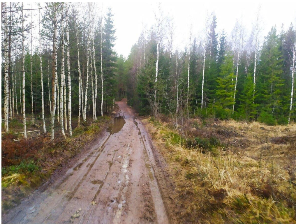
Рисунок 3. Пример неукрепленного проезда с переувлажненным грунтом при незначительной интенсивности движения лесозаготовительного транспорта
