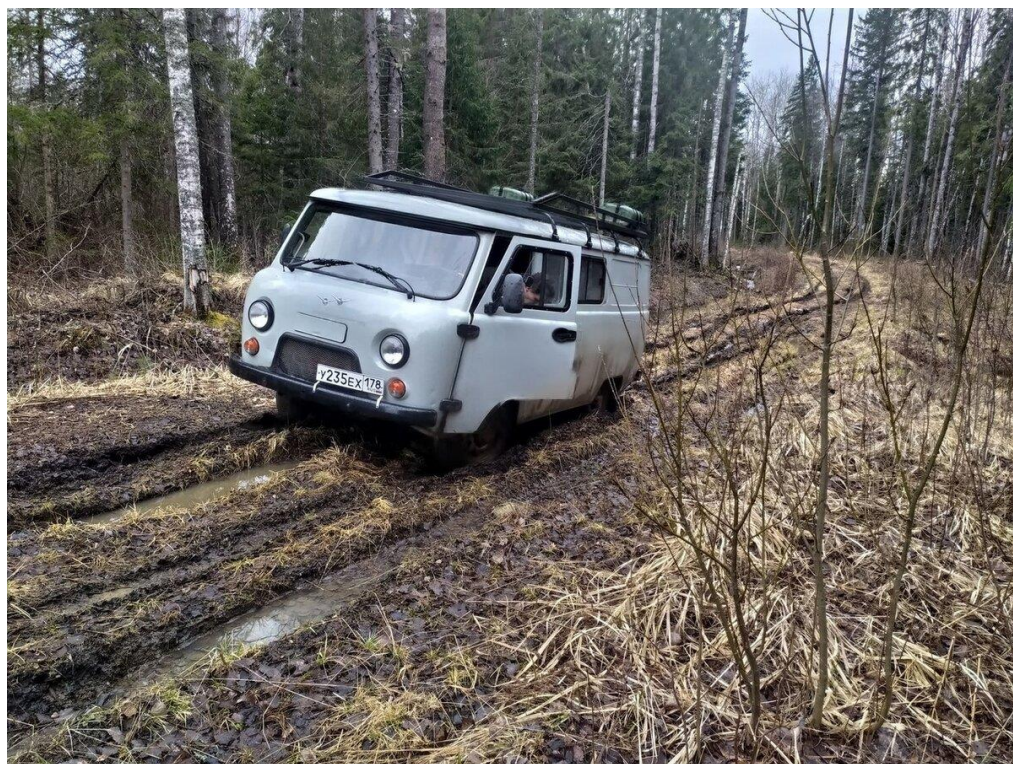
Рисунок 4. Пример неукрепленного проезда с переувлажненным грунтом при незначительной интенсивности движения лесозаготовительного транспорта
