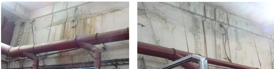
Рисунок 3 - Следы протечек грунтовых вод в уроне отм. -1,50 стен нижнего строения
