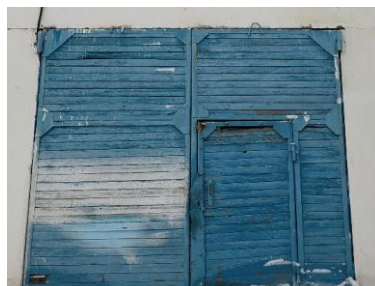
Рисунок 4 - Ветхое дощатое заполнение полотна ворот
