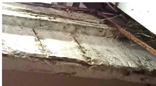
Рисунок 3 - Отслоение защитного слоя бетона, обнажение и коррозия арматуры
