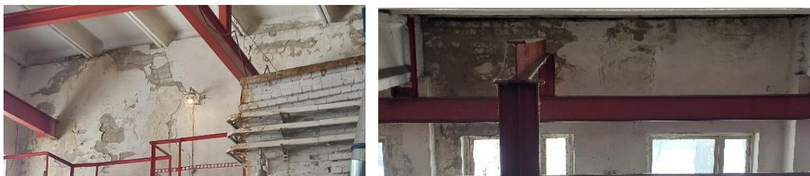
Рисунок 6 - Отслоение штукатурного покрытия наружных стен в помещении коллекторной
