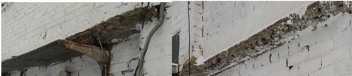
Рисунок 1 - Разрушение защитного слоя бетона, коррозия арматуры железобетонного козырька. В осях А-Б/7 коррозия металлического козырька
