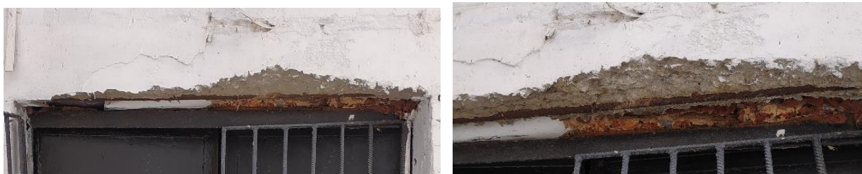
Рисунок 2 - Разрушение защитного слоя бетона, обнажение и поверхностная коррозия рабочей арматуры на участке l \approx 1,0 м
