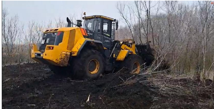
Рисунок 1 – Рабочий момент выполнения корчевания растительности
