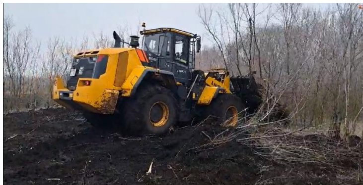
Рисунок 1 – Рабочий момент выполнения корчевания растительности
