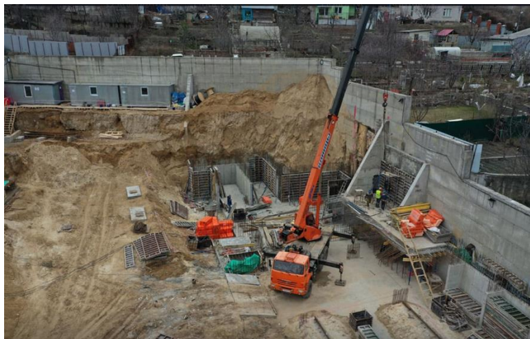
Рис. 2. Возведение подпорной стены
