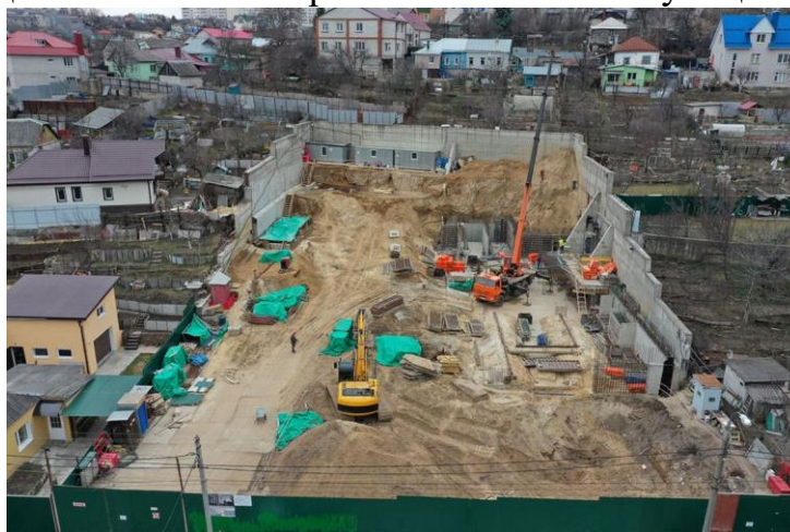
Рис.1. Рассматриваемая строительная площадка
