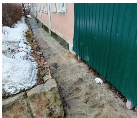
Рис. 3. Фундамент одного из старых домов
