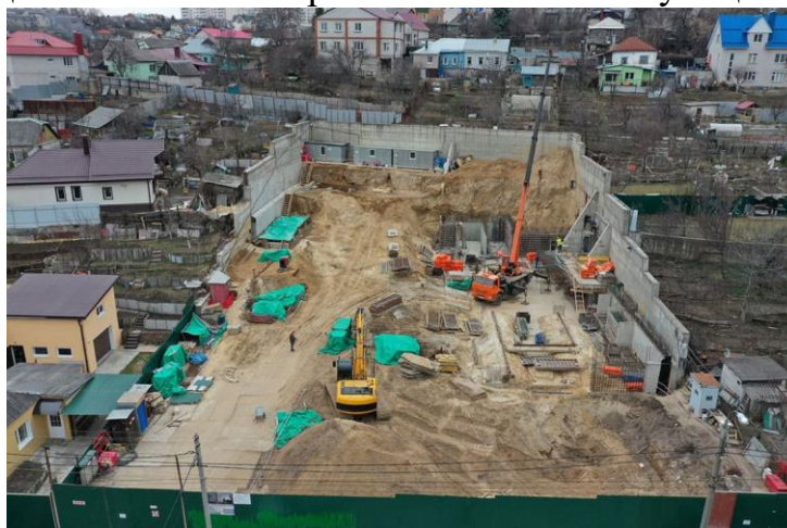
Рис.1. Рассматриваемая строительная площадка
