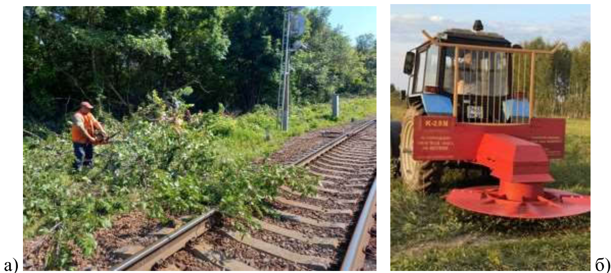
Рисунок 3 – Удаление НДКР методом срезания
