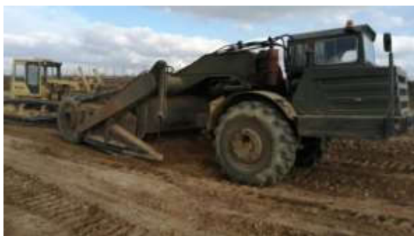
Рисунок 1 – Выполнение скрепером забора грунта с помощью вспомогательной машины-толкача
