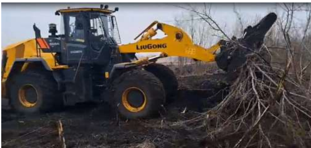
Рисунок 1 – Удаление растительности новым корчевальным оборудованием
