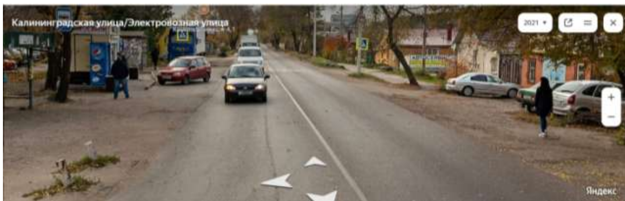
Рисунок 2 – Отсутствие заездных карманов для автобусов на остановке «Гаражи»
