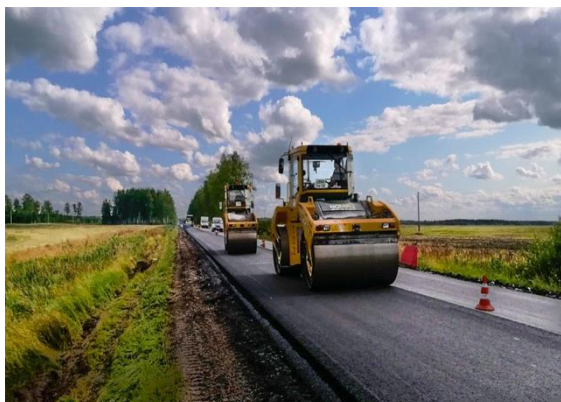
Рисунок 4 – Проведение новых дорог в Тюменской области
