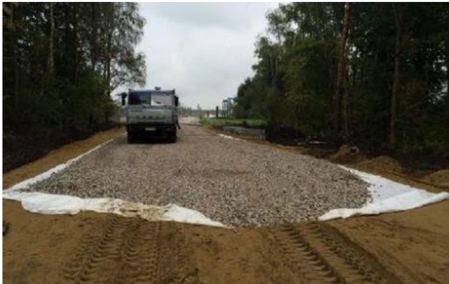
Рисунок 1 – Конструктивные слои дорожной одежды с применением геотекстильного материала
