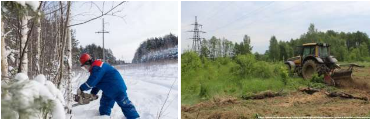
Рисунок 1 – Удаляемая растительность в охранных зонах линий электропередачи
