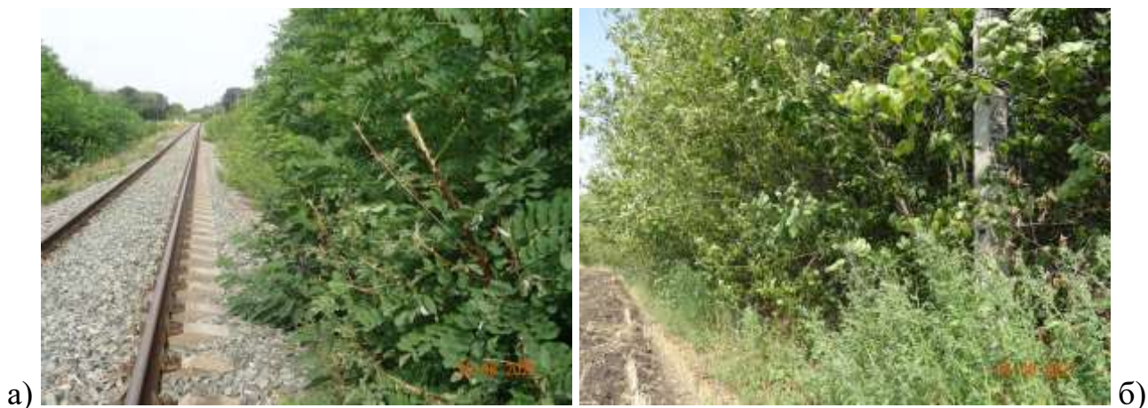
а) железнодорожный участок Готня-Белгород (100 км 6 пк ... 104 км 8 пк, 100 км 7 пк срублена подвижным составом Робиния ложноакациевая), 2021 г., фото автора; б) участок охранной зоны ПС Томаровка – ПС Дмитриевка, 2021 г., фото автора Рисунок 1 – Степень зарастания участков линейного инфраструктурного объекта
