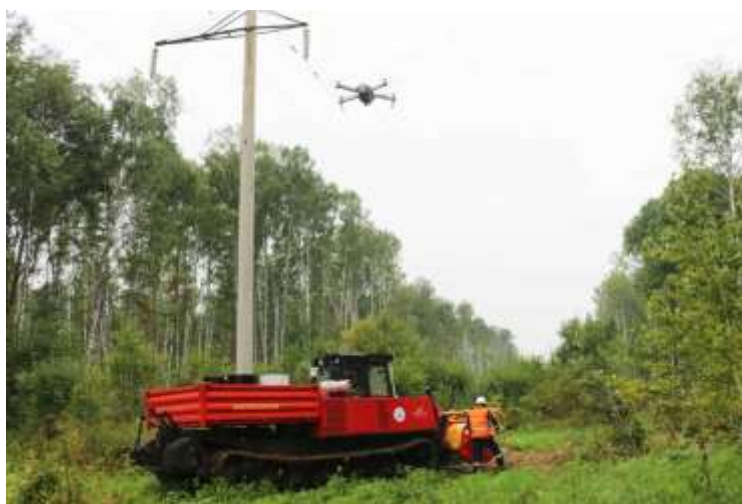
Рисунок 1 – Осмотр труднопроходимых мест при расчистке просек ЛЭП
