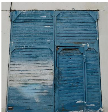
Рисунок 4 - Ветхое дощатое заполнение полотна ворот
