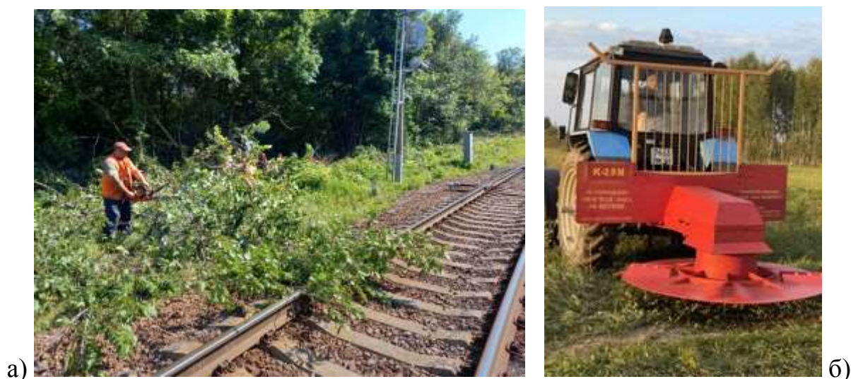
Рисунок 3 – Удаление НДКР методом срезания
