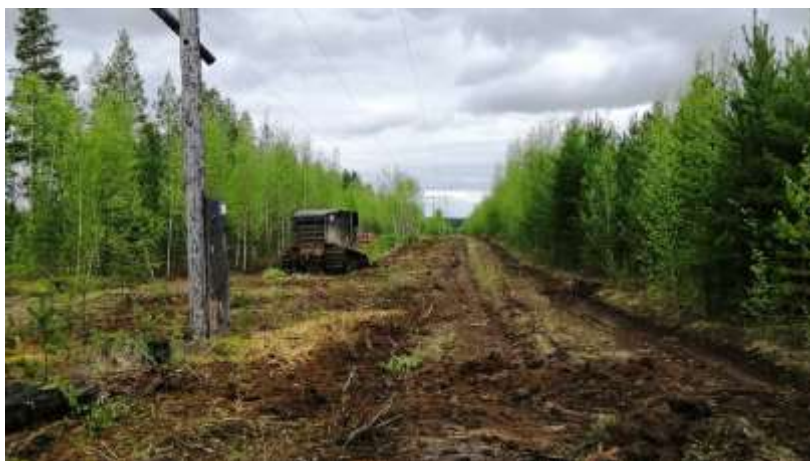
Рисунок 2 – Расчистка просеки ЛЭП в Западной Якутии от растительности
